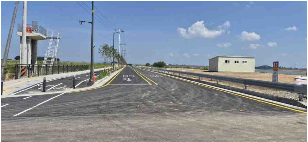
▲ 전경 - (좌) 수문 구조물·내륙측 도로 포장 완료 / (우) 배수펌프실(가설건축물형)은 해안측 도로 끝 흙바닥에 위치
