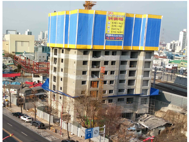
민간 공동주택 시공사진
